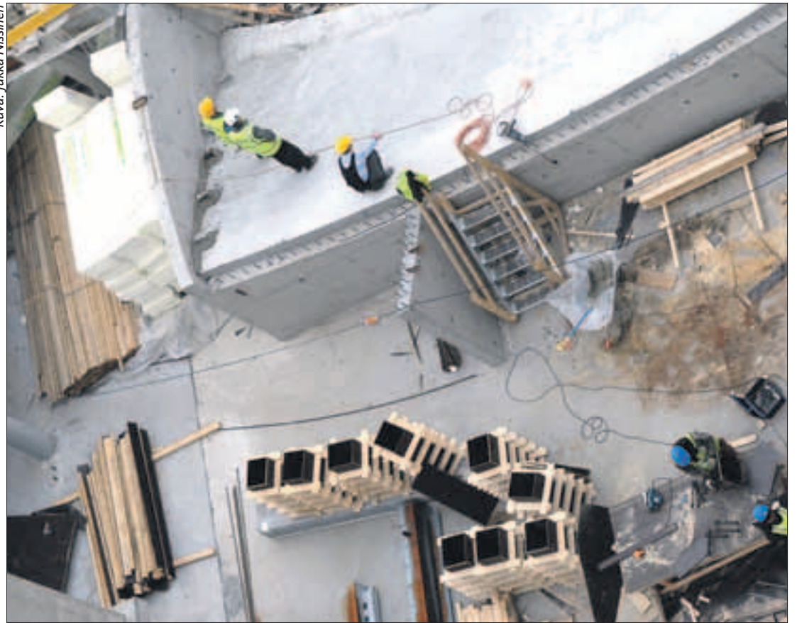
Salmisaaressa rakennetaan! Suomessa rakennus- ja siivousaloilla on paljon ulkomaista liikkuvaa työvoimaa.
